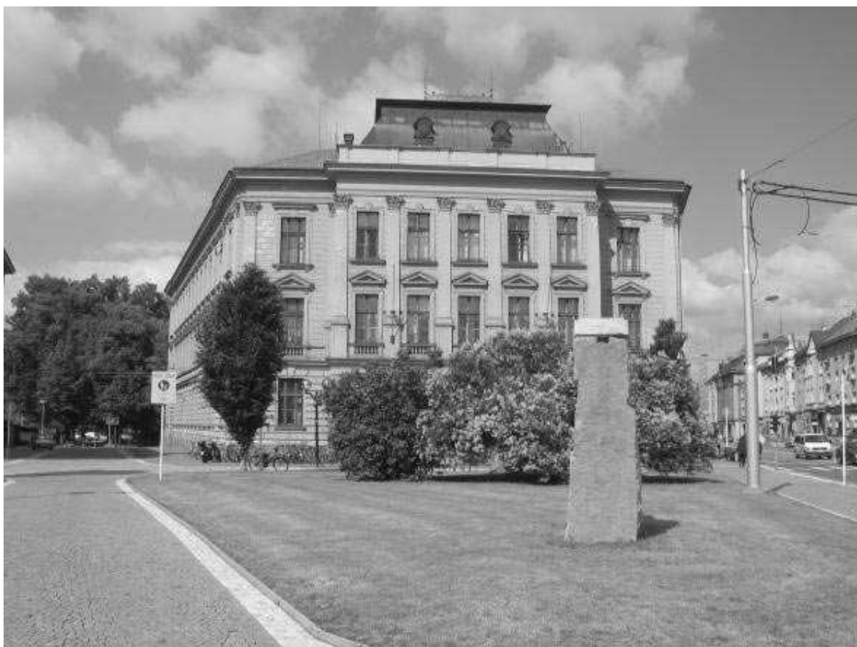
Sídlo katedry informačních technologií FIM UHK
